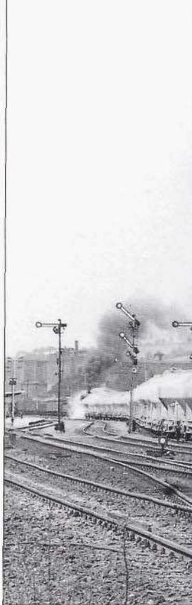
**Bild 3:** Am Westportal des Blankenheimer Tunnels wird das Ende des Schiebetriebes durch das Signal Sp1 (Nachschieben einstellen) angezeigt. Die 44 0101 hat mit ihrem Güterzug Richtung Sangerhausen soeben den Tunnel durchfahren und rollt jetzt die Rampe hinab. **Fotos 3 bis 6: G. Scheibe**
