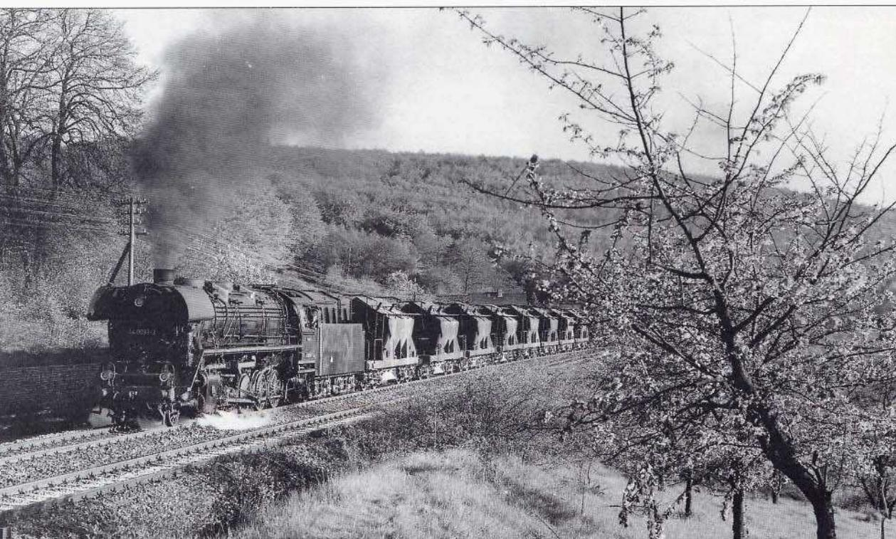
**Bild 10:** Die 44 0093 hat im Mai 1974 mit dem Ganzzug 56403 von Niedersachsen-Süd über den Bahnhof Riestedt durchfahren. Die damals ölgefeuerte 44 0093 ist später auf Rostfeuerung umgebaut worden und fährt heute als Traditionslokomotive.
