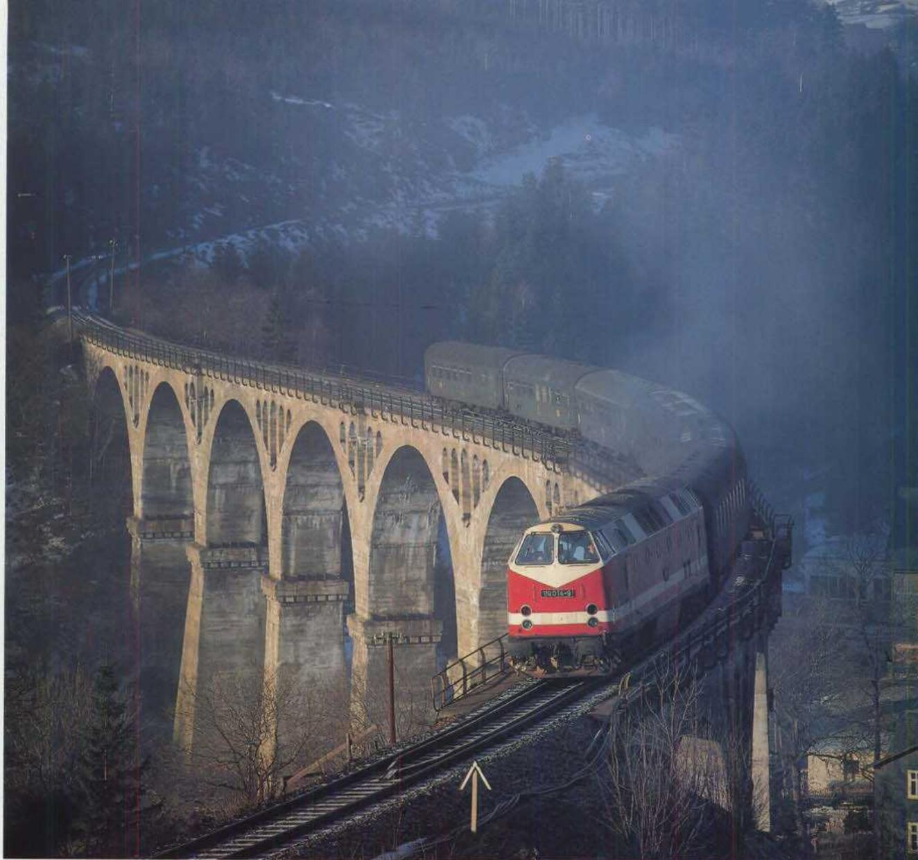
**Bild 12:** Der Viadukt bei Lichte ist wohl das meistfotografierte Motiv der Strecke Sonneberg – Probstzella. Um weniger hohe Pfeiler setzen zu müssen, verlegte man die Brücke im Bogen. **Fotos 1, 2, 4, 11, 12: U. Geum**
