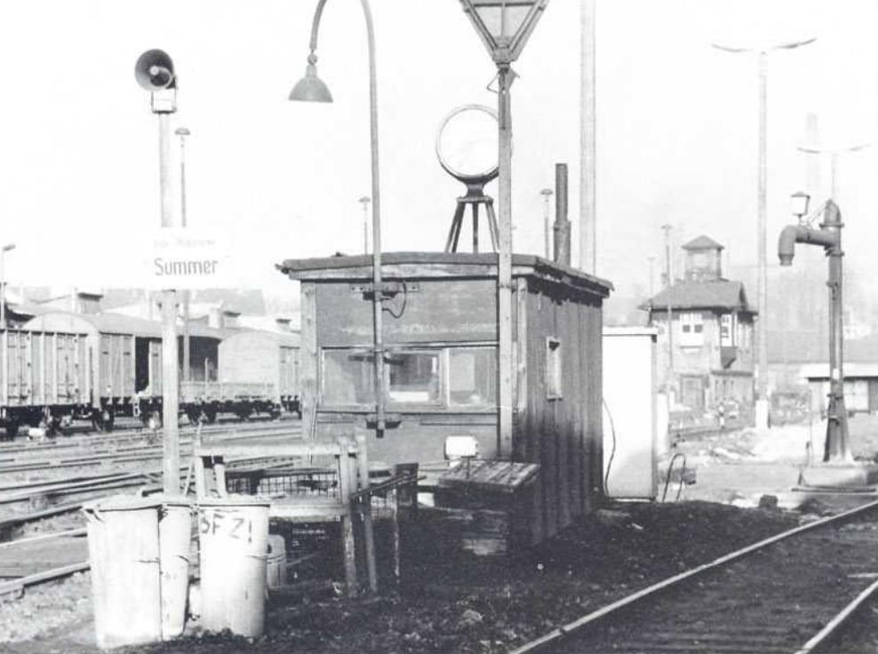
**Bild 13:** Das rechte Gleis führt zur Drehscheibe vor dem Ringlokschuppen. Das Gebäude links ist die Lokübergabestelle; das linke Gleis dient als Sifa-Prüfstrecke.
