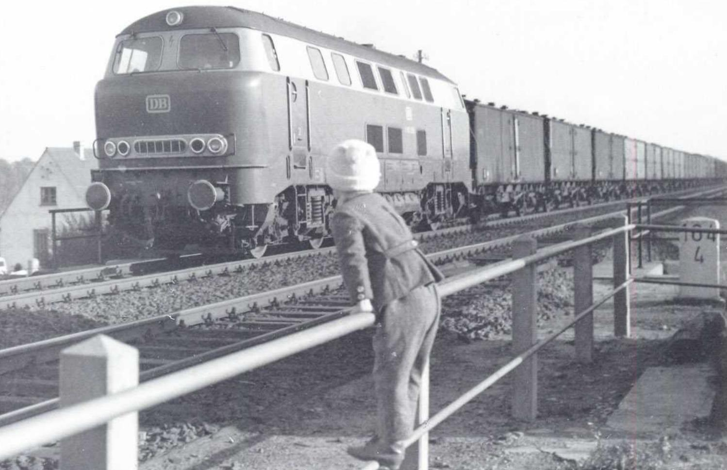
**Bild 3:** Mit einem Güterzug wurde diese Vorserien-V 160 bei Meckelfeld (südöstlich von Hamburg-Harburg gelegen) im Oktober 1961 im Bild festgehalten. Sie befindet sich noch im Anlieferungszustand (mit nur drei Öffnungen im unteren Lüftergitterband).
