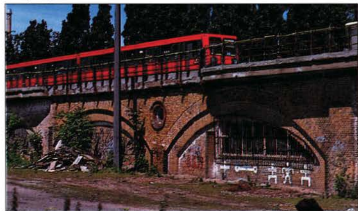
Belastungen: In den Spitzenzeiten begegnen sich jede Minute zwei S-Bahnzüge (Spreebogen; unten); die beiden Diesellokomotiven (Jannowitzbrücke; oben) wiegen zusammen 160 Tonnen.
