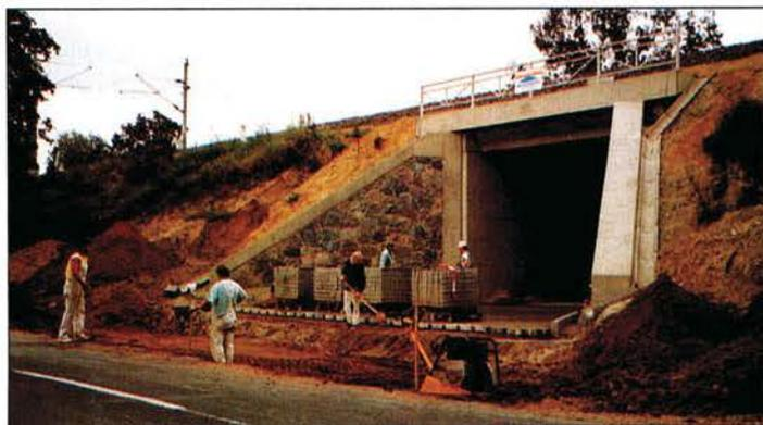
**Ausbaustrasse Berlin-Hamburg:** Bei Breddin wird der Beton eines Durchlasses mit Naturstein verblendet.
