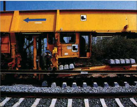
Die Verlegemaschine bringt Schwellen für Schwellen auf den Schotter, richtet sie seitlich und im Abstand aus und fädelt schließlich die Fahrschiene auf die Befestigungsplatte. Die Federklemmen werden erst später festgeschraubt.
