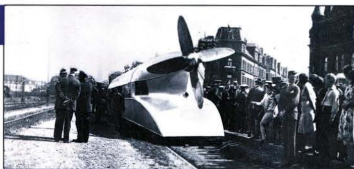
Wie die Aufnahme vom Heck des »Schienenzeppelin« zeigt, hatte sein Konstrukteur Kruckenberg nicht nur den Antrieb vom Vorbild entlehnt: So war bis dahin noch kein Schienenfahrzeug den Erfordernissen der Aerodynamik angepaßt worden.
