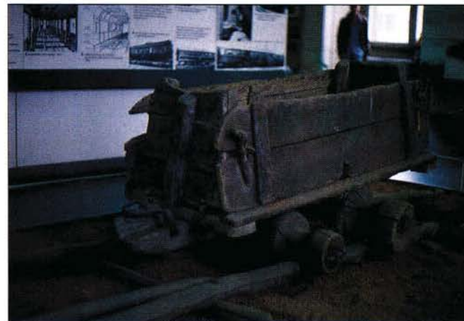
Mittelalterlicher Grubenwagen mit Holzrädern auf Holzschienen im Verkehrsmuseum Dresden
