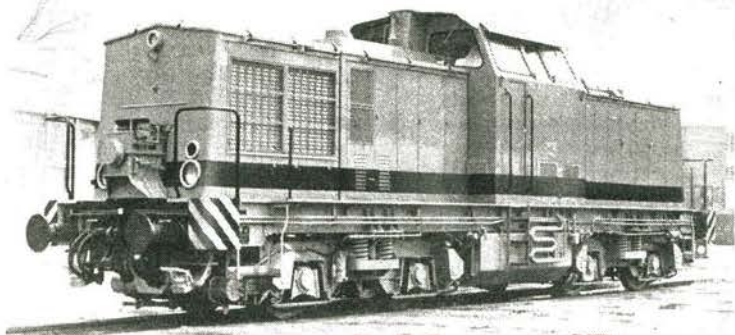
Bild 2 Diesellokomotive, Baureihe V100, Motorleistung 736 kW, Hersteller Kombinat LEW „Hans Beimler“ Hennigsdorf. Die im Bild gezeigte Ausführungsvariante 5 hat als Besonderheit die Möglichkeit zum Anschluß einer Grabenräumeinheit (GRE). Eigens deshalb ist der Dieselmotor mit einem zweiten Abtriebsflansch ausgerüstet. Das für den GRE-Antrieb erforderliche Zwischenlager, untergebracht auf der vorderen Plattform des Umlaufs, ist auf dem Bild erkennbar.
