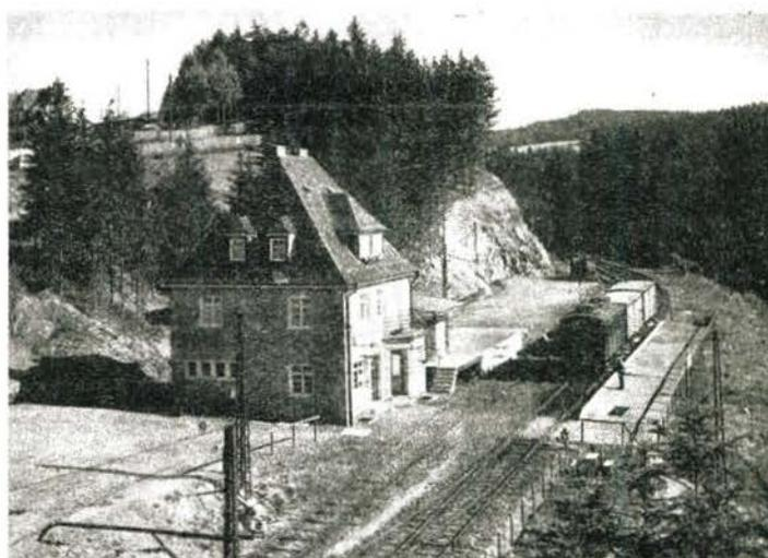
Bild 2 Güterzug zur Bleilochtalsperre im Bahnhof Gräfenwarth um 1930. Das Anschlußgleis zur Sperrmauer bildete die unmittelbare Fortsetzung des Ladegleises, es konnte aber auch über die im Vordergrund sichtbare Weichenverbindung erreicht werden.
