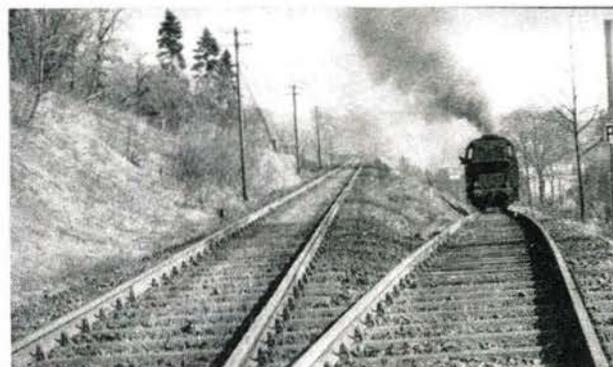
Bild 8 Auf engstem Raum zweigen im Westkopf des Bf Sebnitz (Sachs.) Boden-, Rampen- und Ladegleise ab. Im Hintergrund fährt gerade ein Personenzug aus Richtung Bad Schandau in den Bahnhof ein (1965).
