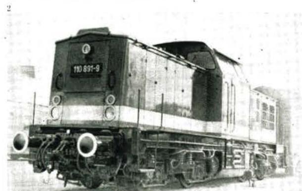
Bild 2 Dieselhydraulische Lokomotive, Baureihe 110
