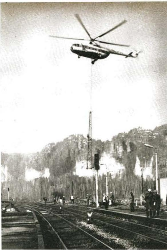
Bild 3 Aufstellen von Fahrleitungsmasten mit Hilfe von Hubschraubern der Interflug im Bf Kurort Rathen
