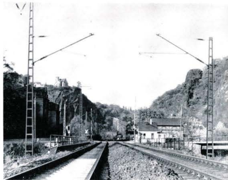
Bild 9 Blick in den Plauenschen Grund bei Dresden
