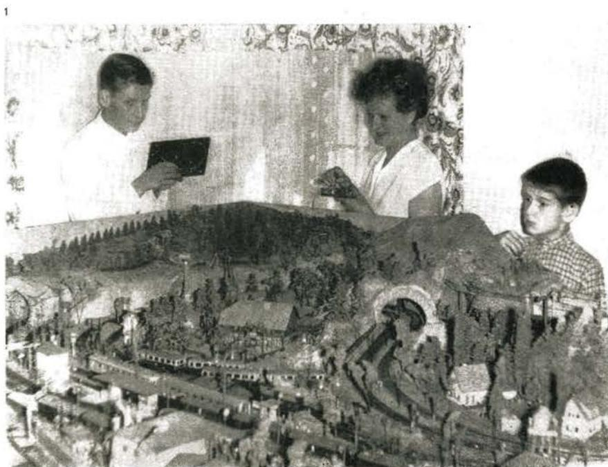
Bild 1 Jeder kann gemeinsam „seinen“ Zug unabhängig voneinander fahren lassen. Die Schaltungen erfolgen nach der „Fernbedienungs-Methode“ des Herrn Haufe
