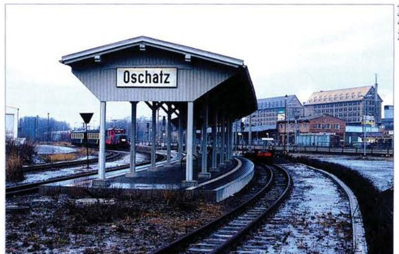
Im Bahnhof Oschatz entstand für die Schmalspurzüge nach Mügeln ein neuer Bahnsteig, der ein bequemes Ein- und Aussteigen ermöglicht. Das Gleis für den Bahnsteig S1 ist dabei als Stumpfgleis angelegt.
