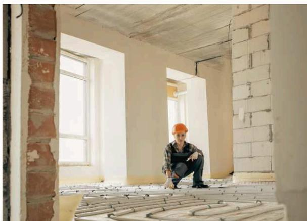
Die Vorlauftemperatur der Fußbodenheizung ist entsprechend der Heizungsanlage ausgelegt und beträgt höchstens 35° C.
