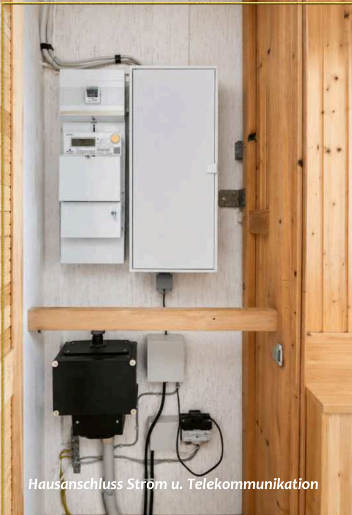
Starkstromanschluss im Nebengebäude
