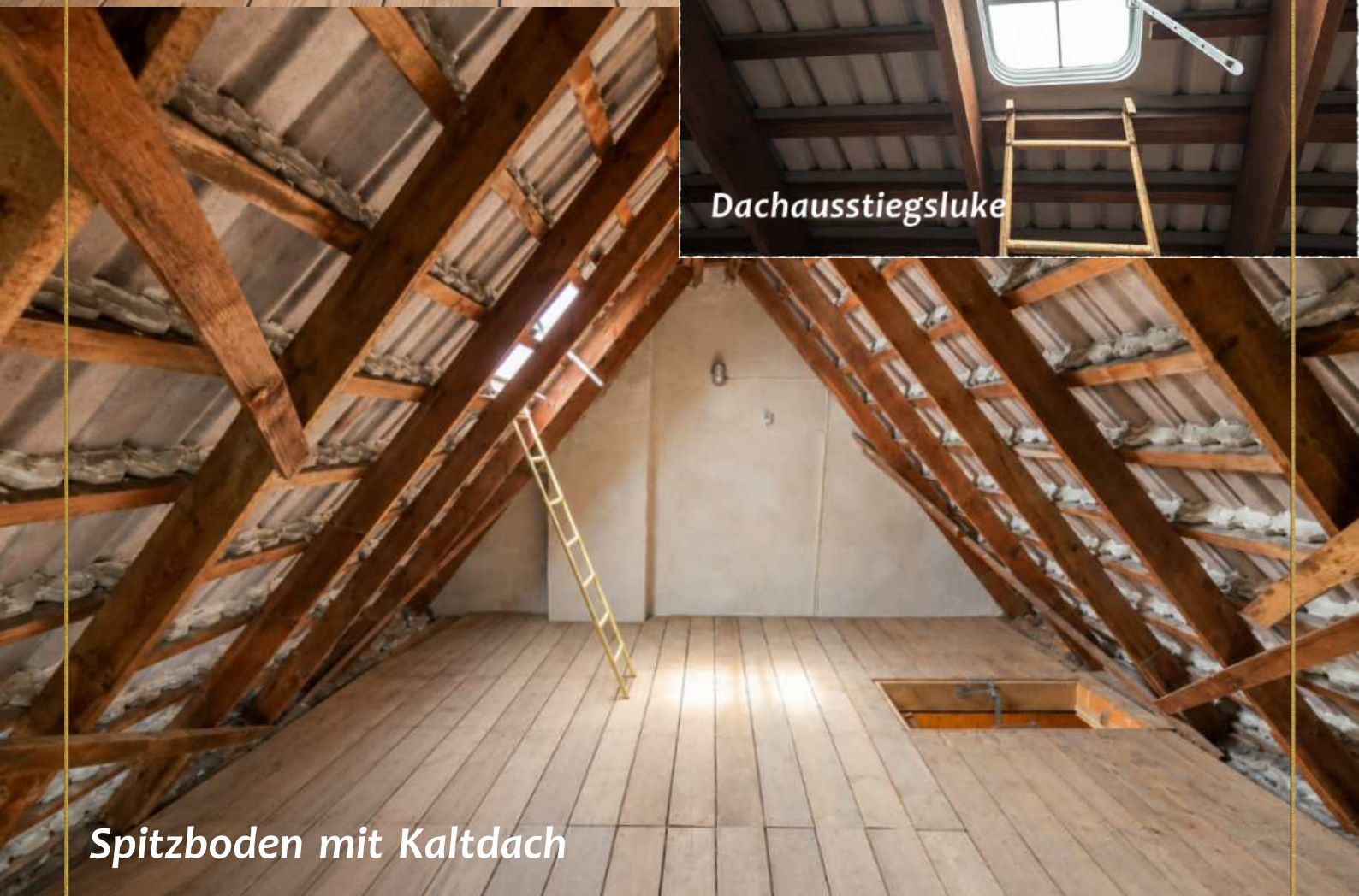
Spitzboden m. gedämmter Geschossdecke
