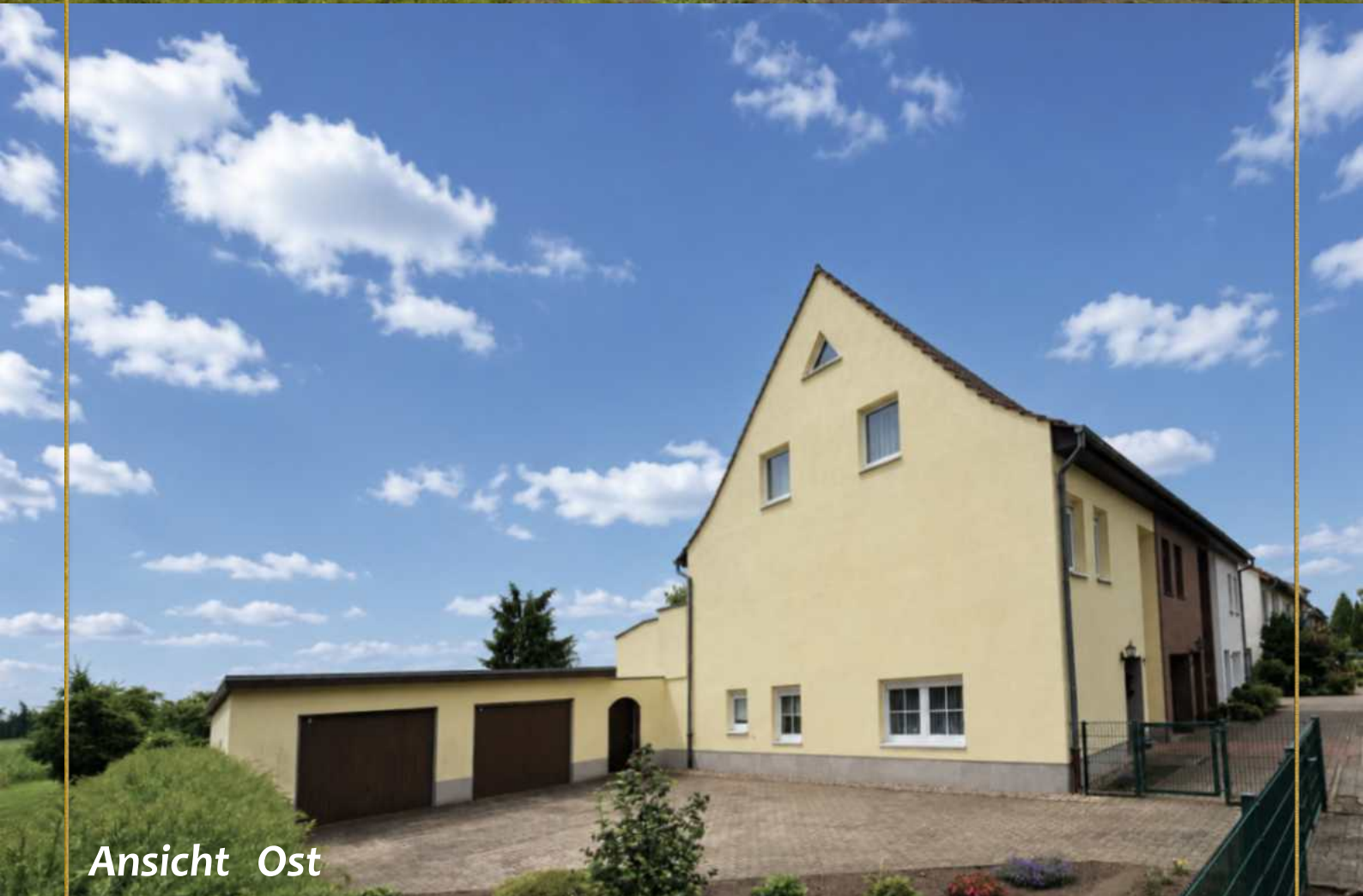
Vorgarten m. Pkw-Stellflächen u. Doppelgarage
