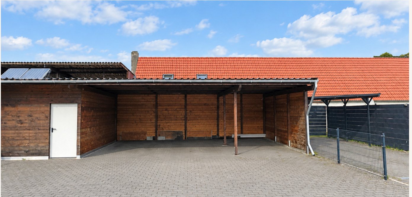
Carport mit drei überdachten Stellplätzen und Geräteraum
