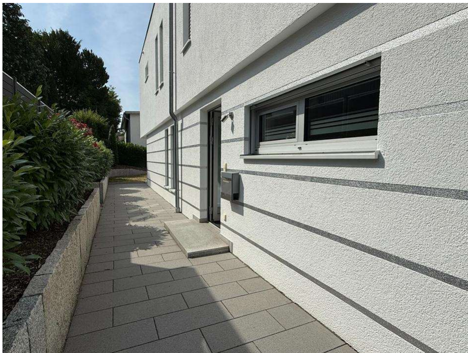
Erdgeschossseinheit mit separatem Ostzugang
