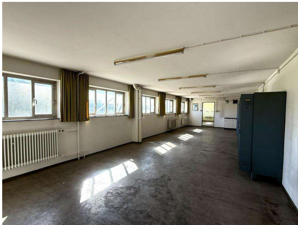
OG - Umkleiden und Sanitärbereich
