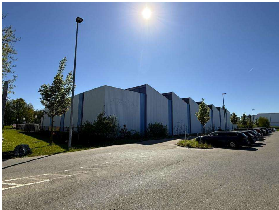
perfekte PV-Ausrichtung der Dachflächen
