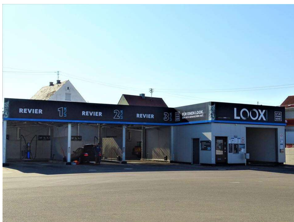
neuer Autowaschpark ist ebenso auf dem Areal
