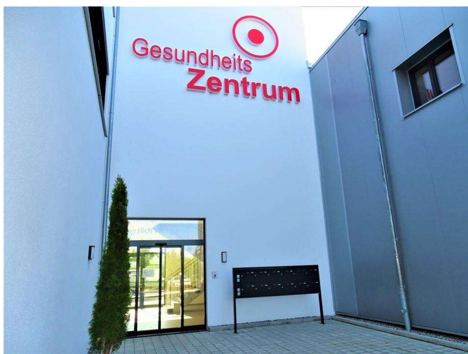
elektrische Türen mit moderner Briefkastenanlage
