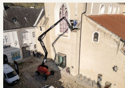
Eine Gelenk-Teleskopbühne aus dem HKL MIETPARK überzeugt mit ihrer Geländegängigkeit und Standfestigkeit und gewährleistet sicheres und flexibles Agieren trotz starkem Gefälle.
