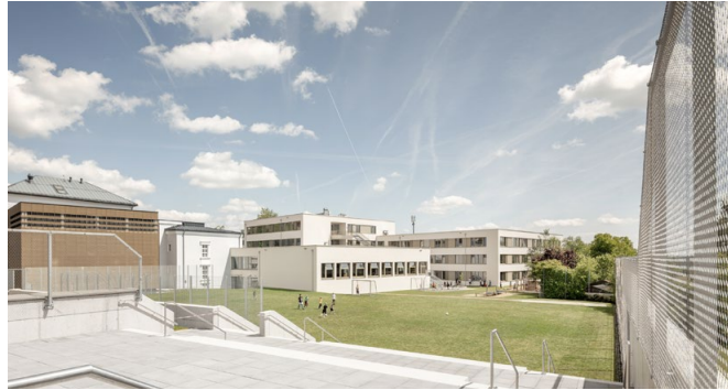
Das neue Schulzentrum in Rohrbach-Berg (ÖÖ) nutzt das Dach des neuen Eurospar-Marktes als Spiel- und Freizeitfläche für die Schülerinnen und Schüler.
