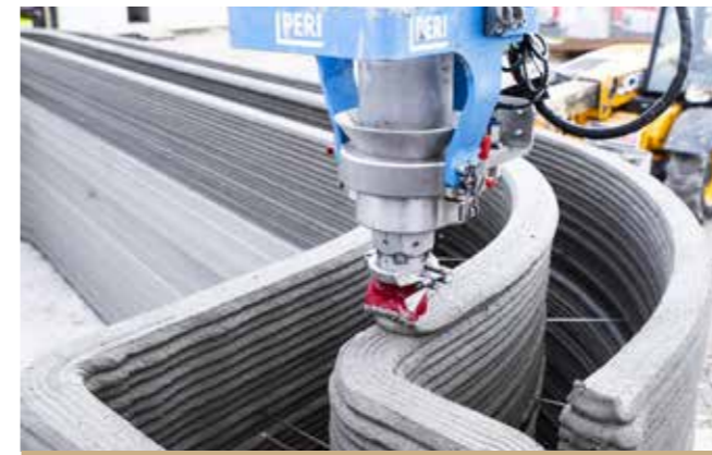
Der 3D-Drucker trägt das Druckmaterial (Trockenmörtel) schichtweise auf
