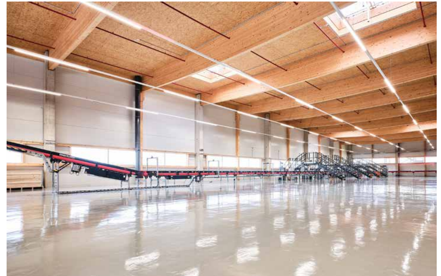
In Rekordzeit gebaut: Rubner erstellte in nur drei Monaten die Tragstruktur der Halle sowie Dach- und Außenwände für das modernste Paket-Logistikzentrum der Österreichischen Post. (Foto: © Michael Liebert)
