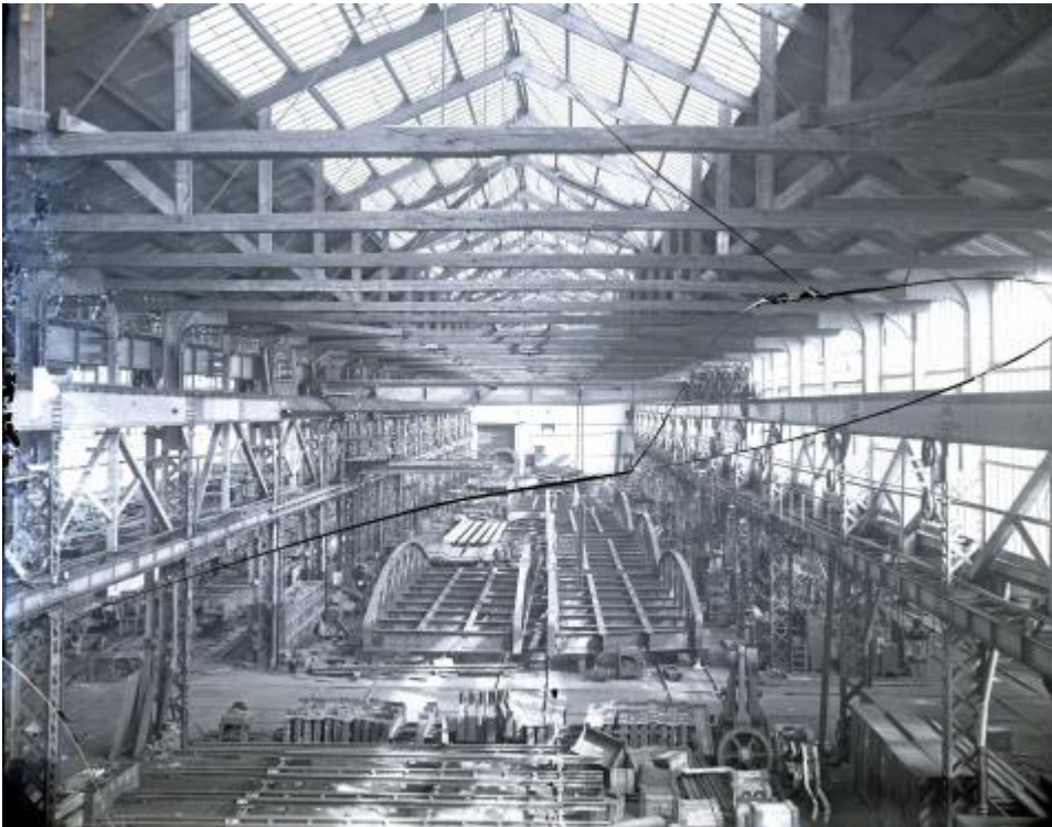
Pont Pirée Demirly. Vue d'ensemble de plusieurs travées en atelier de montage, Cde 280. 02/03, (SAICOM, Fonds Baume et Marpent, BAUM_CV_267).
