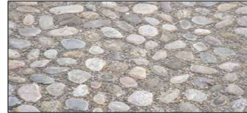
p1 pavimentazione in sassi di fiume
