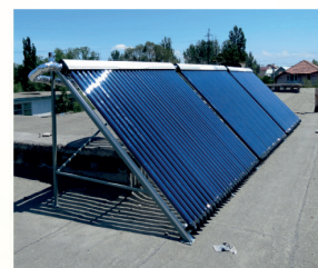
Солнечный коллектор, применяемый для отопления и горячего водоснабжения зданий (г. Бишкек)
