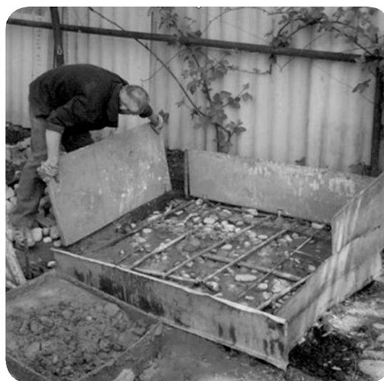
**ТЕХНИЧЕСКИЕ СЕКРЕТЫ:** Перед заливкой бетона и укладкой армированной сетки дно площадки под фундамент можно выложить камнем для экономии бетонного раствора. Кроме того, при заливке раствора можно добавлять камни размером 5-10 см - это сэкономит ваш бюджет и укрепит фундамент. Во время заливки необходимо утрамбовывать раствор, чтобы он равномерно залил всю поверхность во избежание образования пустот, для этого используют кусок арматуры или палку.
