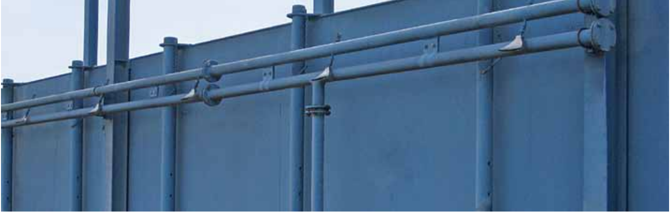
Sprüheinrichtung der Putsch® Rundkläranlage zur gezielten Reduktion der Schaumbildung Dispositif d'aspersion du bassin de décantation Putsch® pour réduire la formation de mousses Разбрызгивающее устройство Putsch® радиального отстойника для уменьшения образования пены
