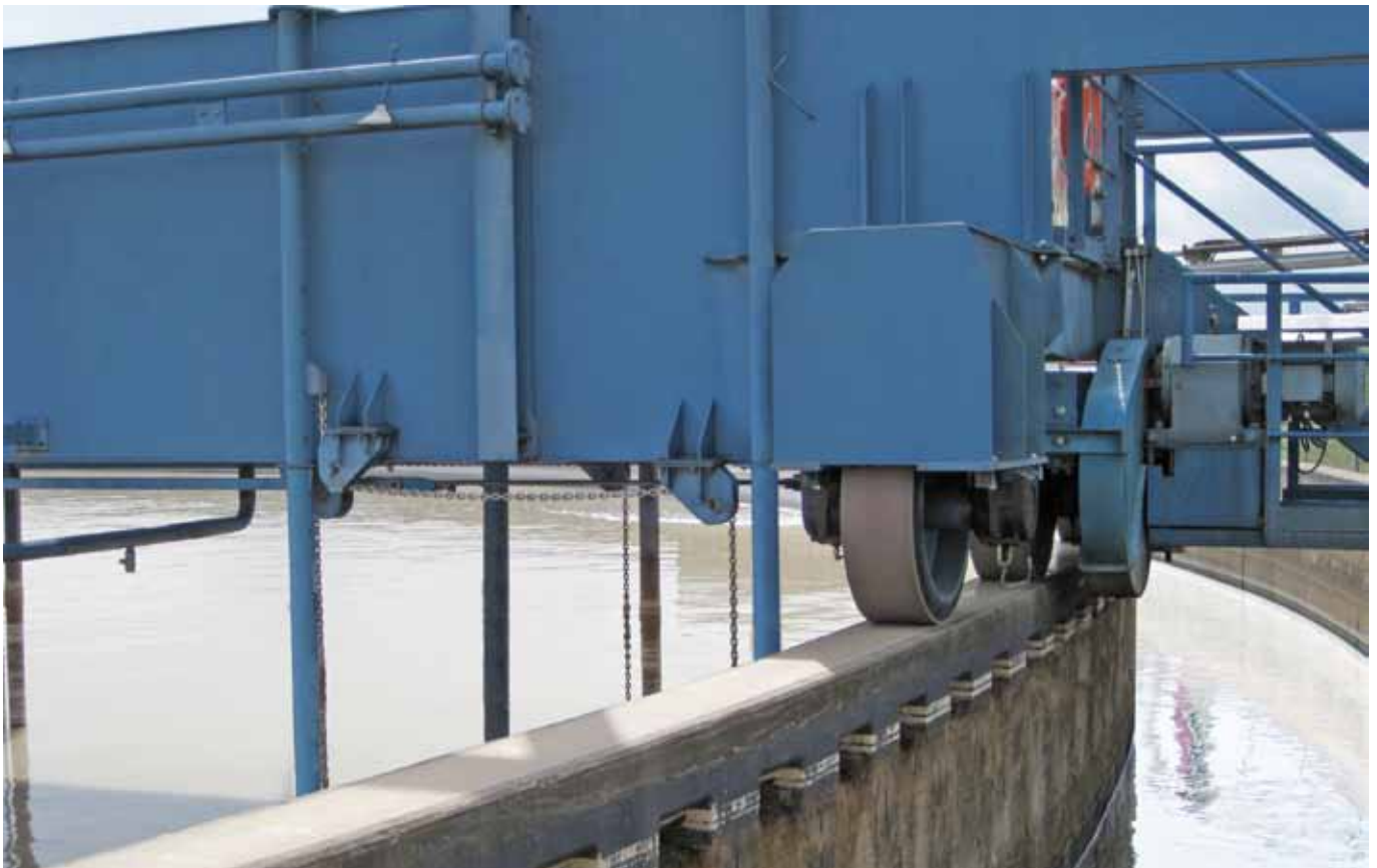
Antriebsräder der drehbaren Räumerrücke einer Putsch® Rundkläranlage Roues motrices du pont racleur pivotant d'un bassin de décantation Putsch® Ведущее колесо вращающейся фермы Putsch® радиального отстойника
