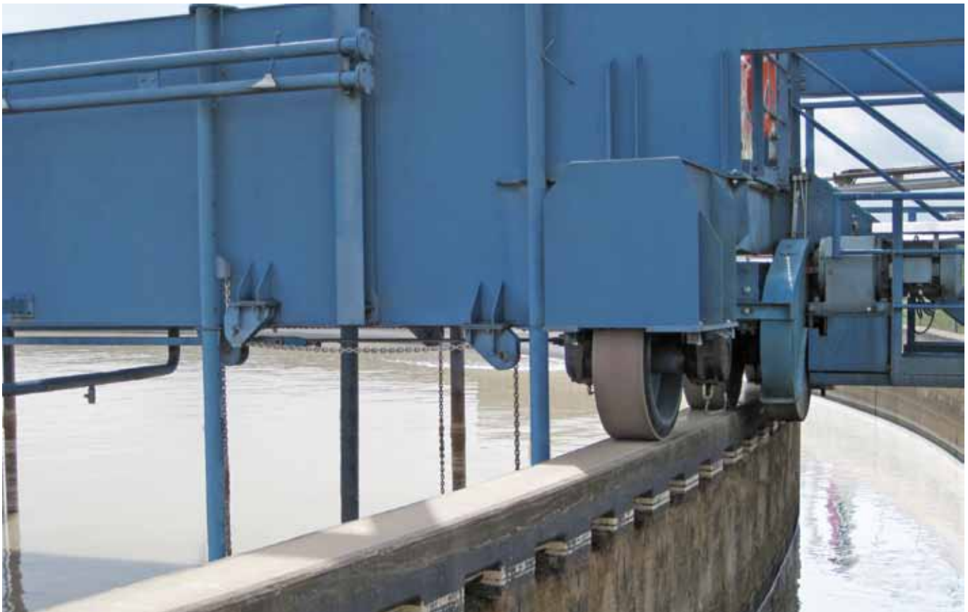
Antriebsräder der drehbaren Räumerbrücke einer Putsch® Rundkläranlage Driving wheels of the rotating scraper bridge of a Putsch® Flume Water Clarifier Ruedas de tracción del puente giratorio limpiador de un depósito clarificador Putsch®
