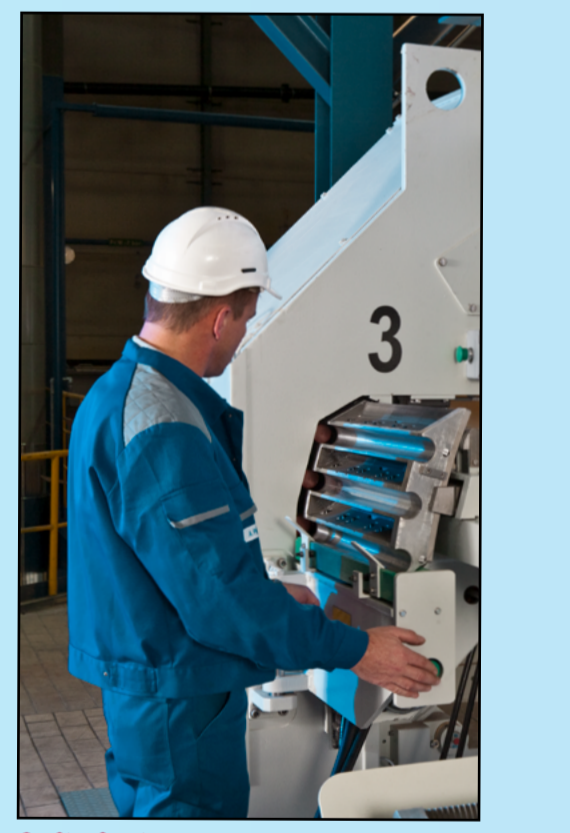
On-Site Service / Maintenance / Servicio in situ / Mantenimiento
