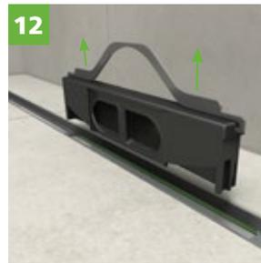
**Gebruik voor het verlijmen van de meegeleverde Greenlox-flens flexibele tegellijm EN 12004:CZE-S1 (in de handel gekend als 'superflexlijm'). Voor de overlappende delen gebruikt u een 2-componentenlijm.**
