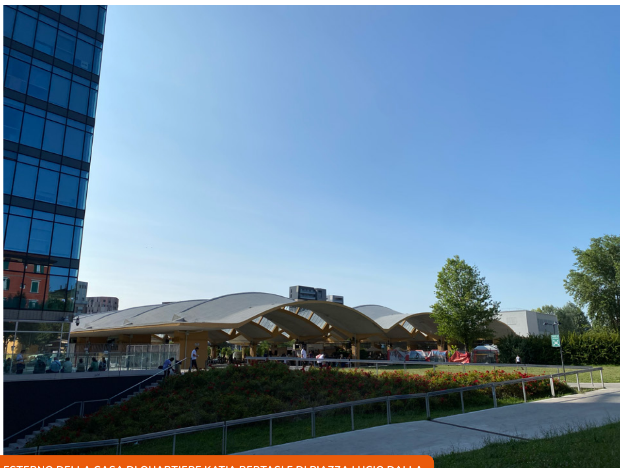
ESTERNO DELLA CASA DI QUARTIERE KATIA BERTASI E DI PIAZZA LUCIO DALLA
